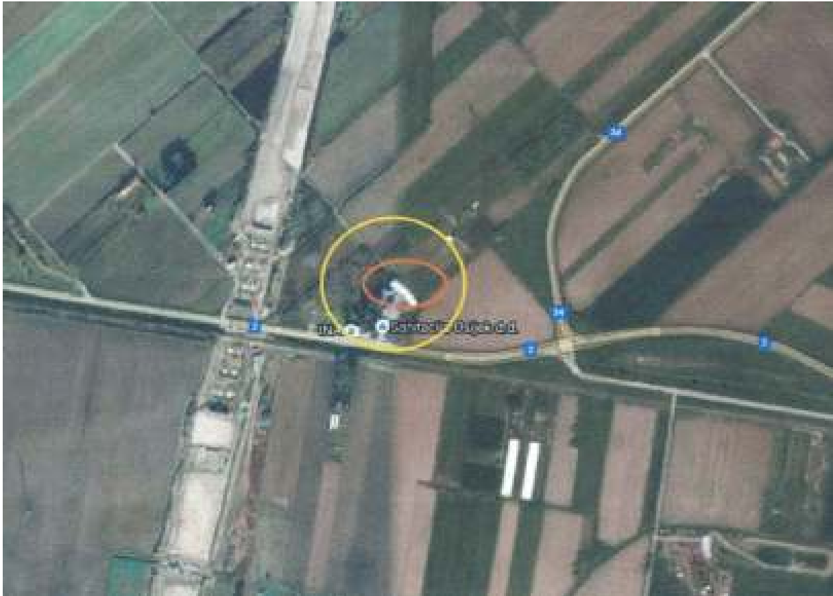
Slika 2.3.15 – 1 Eksplozija skladišta fostoksina
