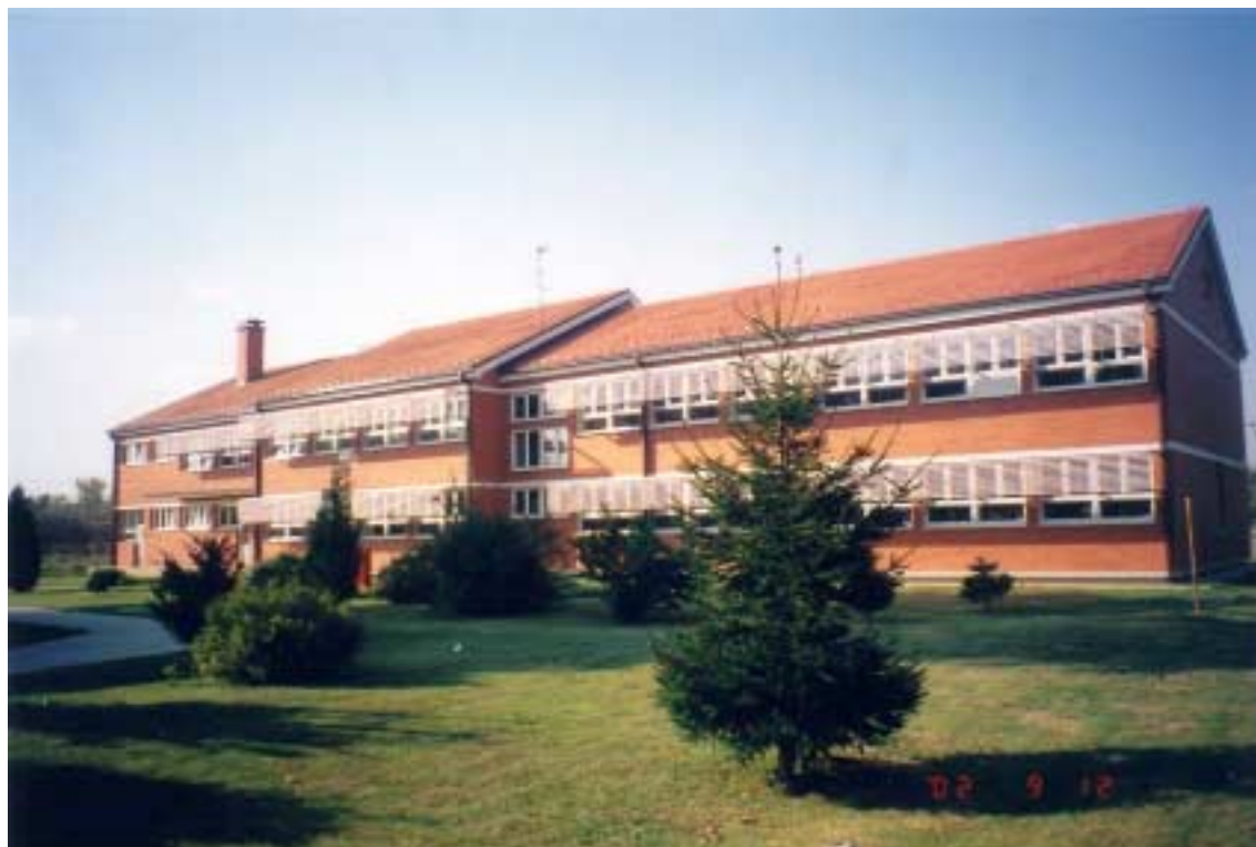
Nova zgrada osnovne škole u Petrijevcima
